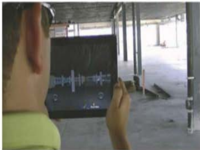
Visualisation de l'état futur sur une tablette d'un point de vue choisi sur site (Source : Javelin reality)
